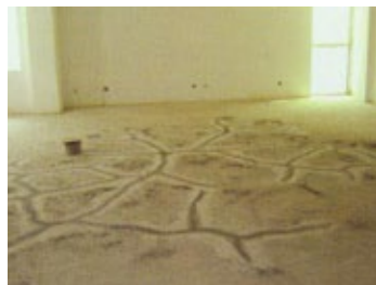
混凝土裂缝的修补
